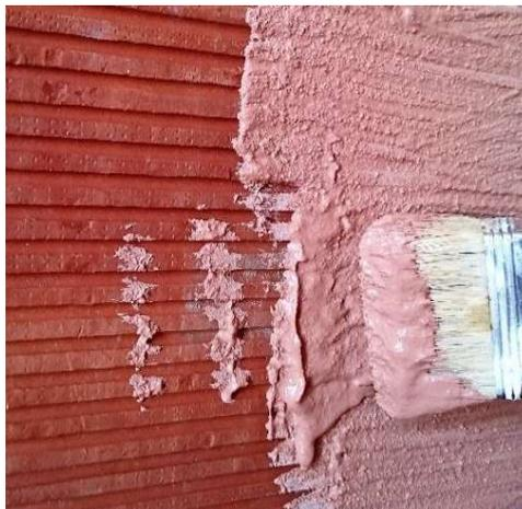
**COMPOSIZIONE:** Miscela di calce idraulica naturale, inerti selezionati, cocciopesto filerizzato, additivi naturali, da impastare con acqua potabile fino a consistenza fluida.
