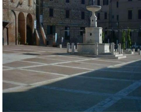
**COMPOSIZIONE:** Il massetto è composto da un impasto di aggregati di cocciopesto, in adeguata curva, inerti silicei, legante a base di calce naturalmente idraulica (FL-15)
