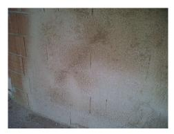
**COMPOSIZIONE:** miscela composta da inerti selezionati aventi una curva granulometricada 0 a 3 mm, calce idraulica naturale, cocciopesto e composti di qualità superiore che ne migliorano le proprietà di adesione al supporto.
