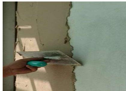
**IMPIEGO:** La finitura, molto traspirante, da utilizzare come rivestimento o finitura, ad effetto rustico, su intonaco di calce o calce-cocchiopesto, oppure anche come rivestimento colorato di finitura per intonacitradizionali o premiscelati; in questi casi testare il prodotto sulle superfici d'applicazione per meglio verificare il risultato finale. Specifica per ciclo intonaci per risanamento da umidità interstiziale.
