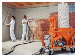
**L'intonacatrice** da noi consigliata è tipo la macchina intonacatrice **PFT G4**, miscela e pompa le malte premiscelate a secco miscelate in fabbrica. L'intonacatrice intelligente PFT G4 può essere riempita tramite sacchi oppure può essere posizionata direttamente sotto un silo con cappa di mandata. Consigliamo un miscelatore tipo plus zincato (es mixer technology), un polmone con vite avente portata massima da **22 a 24 litri d'acqua** e una pressione massima di **30 BAR**.
