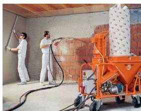
**L'intonacatrice** da noi consigliata è tipo la macchina intonacatrice **PFT G4**, miscela e pompa le malte premiscelate a secco miscelate in fabbrica. L'intonacatrice intelligente **PFT G4** può essere riempita tramite sacchi. Consigliamo un miscelatore per intonaci leggeri isolanti, un polmone **con vite** avente portata massima da **27 a 29 litri d'acqua** e una pressione massima di **30 BAR**.
