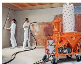
**L'intonacatrice** da noi consigliata è tipo la macchina intonacatrice **PFT G4**, miscela e pompa le malte premiscelate a secco miscelate in fabbrica. L'intonacatrice intelligente **PFT G4** può essere riempita tramite sacchi. Consigliamo un miscelatore tipo **plus zincato** (es mixer technology), un polmone **con vite** avente portata massima da **22 a 24 litri d'acqua** e una pressione massima di **30 BAR**.
