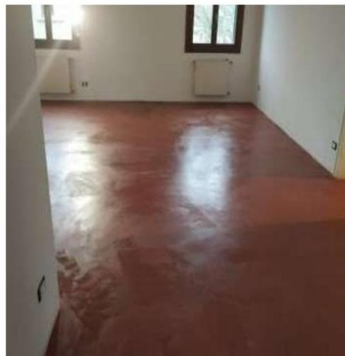
**COMPOSIÇÃO:** a mistura seca é constituída por uma mistura pulverulenta monocomponente à base de agregados de quartzo, ligantes pozolânicos, cal hidráulica natural (NHL), caulino, aditivos orgânicos e silicatos naturais específicos. É fornecido em três tamanhos de grãos diferentes: Inferior (1,2 mm), Fino (0,6 mm) Extrafino (0,3 mm). Pode ser classificado como um produto bioecológico. A mistura é obtida adicionando água potável ou destilada à mistura seca.
